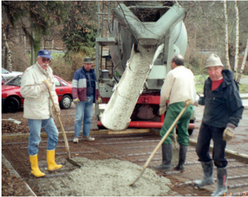
Parkplatz-Sanierung in Eigenleistung
