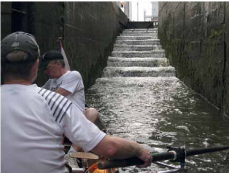
...Wasserbau vom Feinsten
